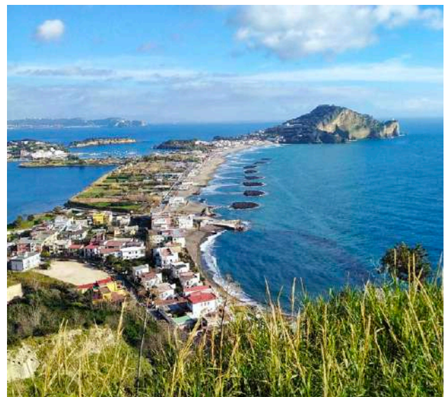
Spiaggia di Miliscola-Miseno (Bacoli, Napoli), dove sono presenti dagli anni '60-'70 alcune scogliere emerse discontinue, parallele alla costa, per contrastare l'erosione della spiaggia.
