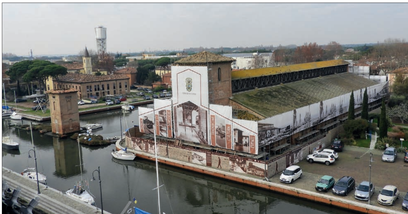
Il Magazzino del Sale in corso di restauro.
