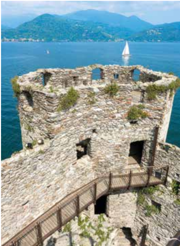
Il percorso di visita ha recuperato gran parte dei tragitti di ronda.
